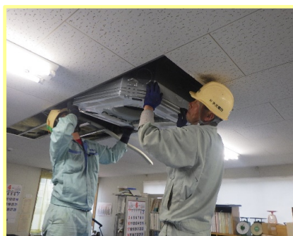
省エネエアコンの取付
